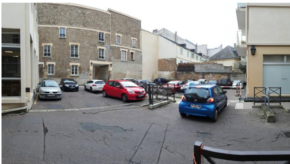
Etat actuel de la dalle du parking souterrain : revêtement bitumineux très dégradé
